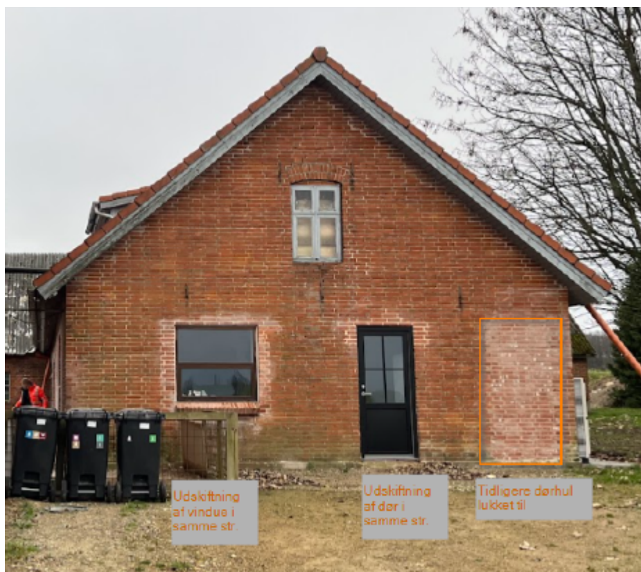
Bygning 3 – Eksisterende facade mod nordøst
