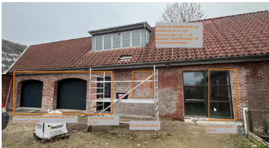
Bygning 3 – Eksisterende facade mod sydøst
