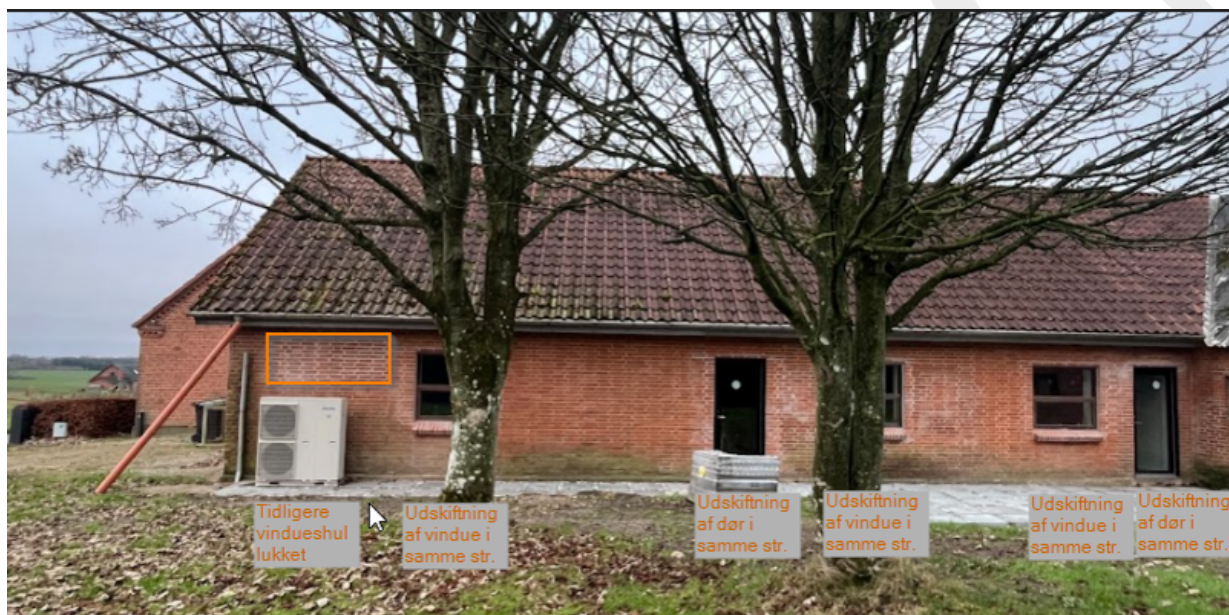
Bygning 3 – Eksisterende facade mod nordvest
